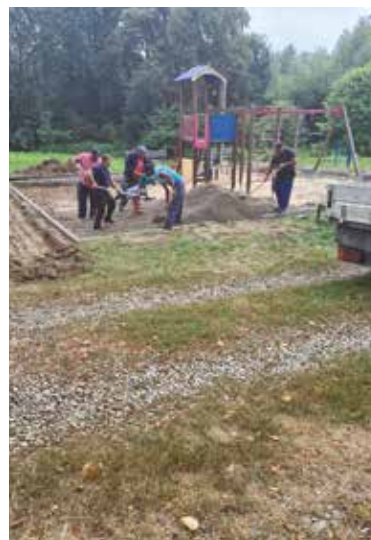
Práce na novom povrchu (foto: redakcia)
