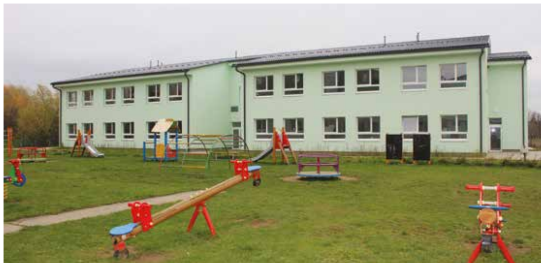
Novostavba materskej školy (foto: redakcia)
