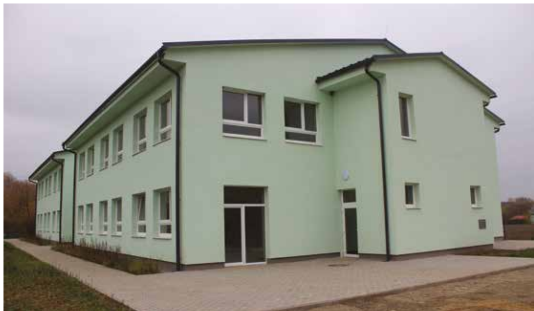
Novostavba materskej školy (foto: redakcia)
