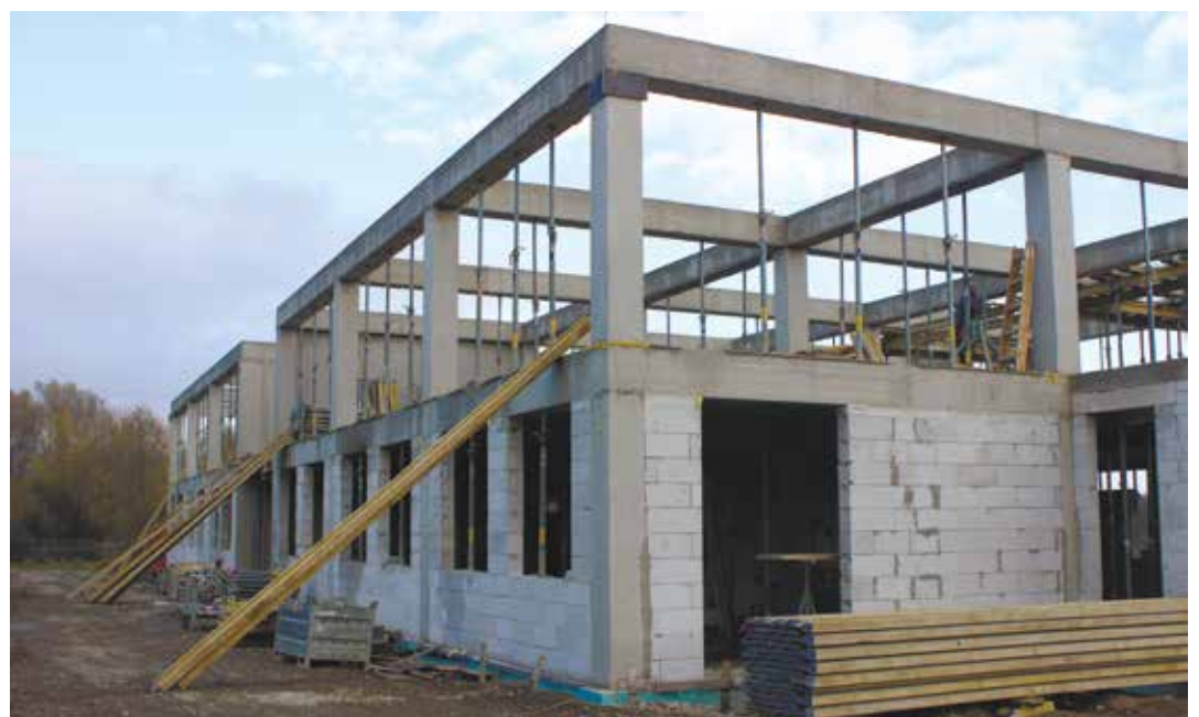
Rozostavaná budova materskej školy (foto: redakcia)
