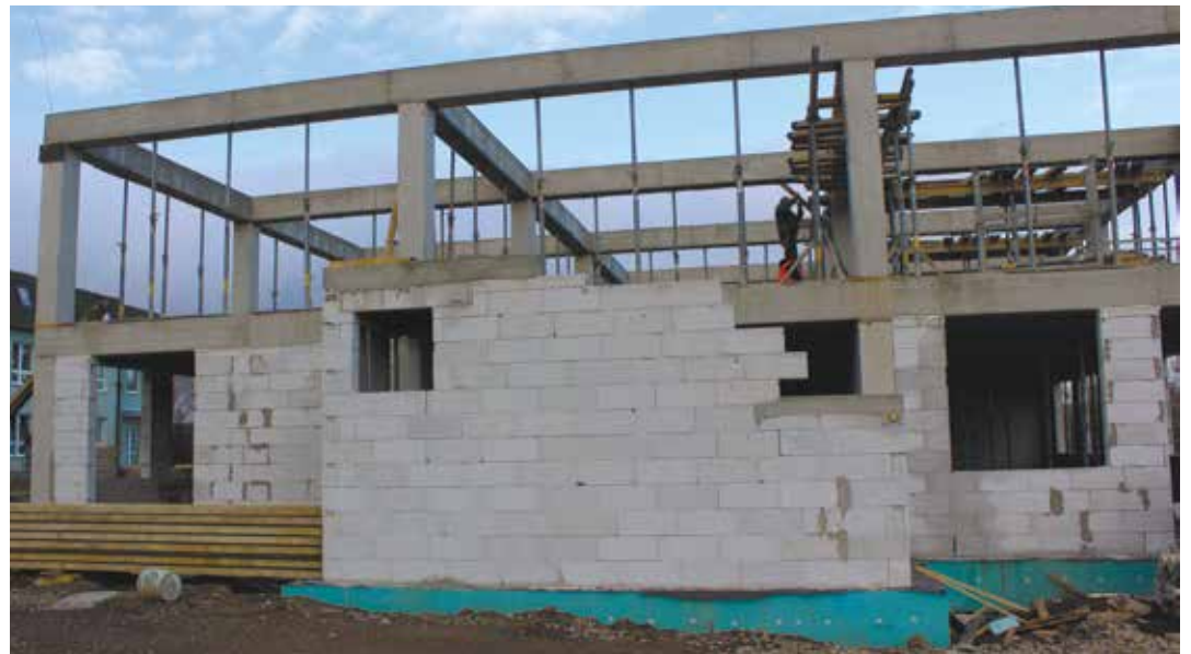
Rozostavaná budova materskej školy (foto: redakcia)
