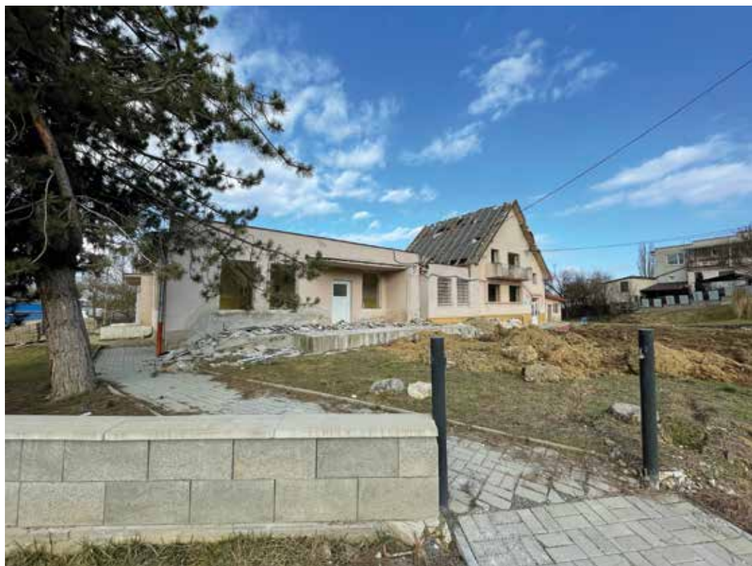
Stavebné práce na zdravotnom stredisku (foto: redakcia)
